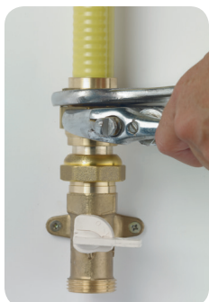
Terminer le serrage en butée
