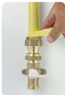
Après avoir effectué le test d'étanchéité, poser la bande jaune auto-adhésive
